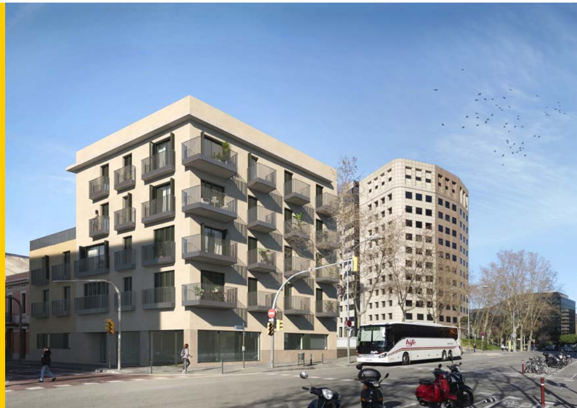
EDIFICI NUMÀNCIA LES CORTS
