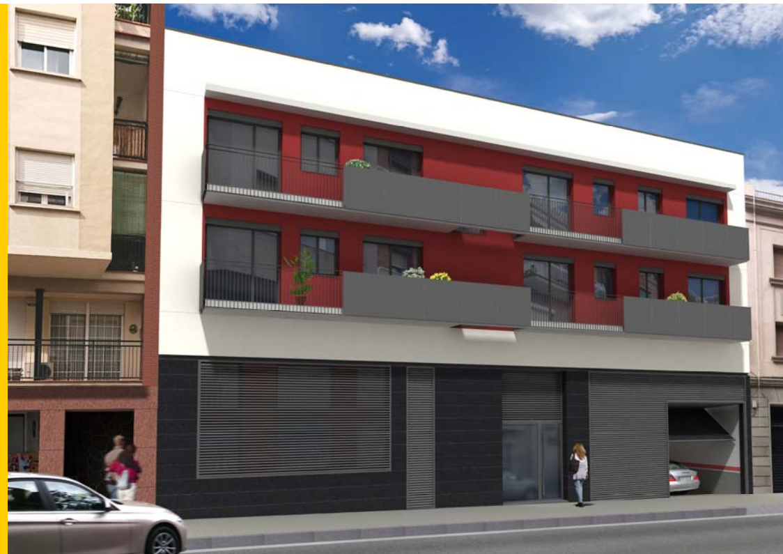
EDIFICI AMÍLCAR GUINARDÓ
